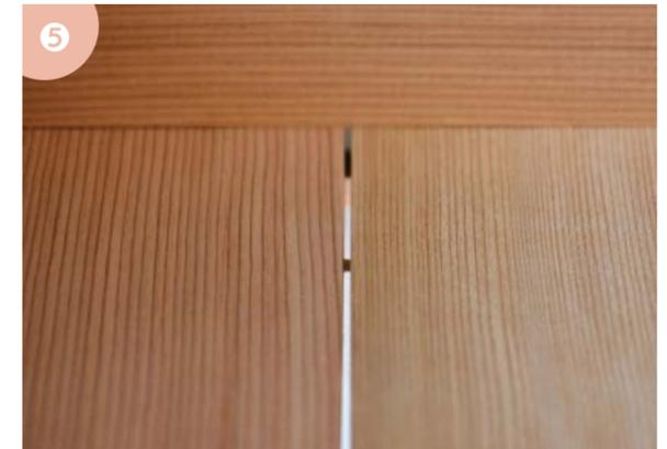
底板は適度なすきまを残しながら、竹釘で補強しています
